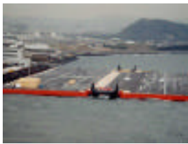
Megafloat Information Base L200m x B100m x D2m
